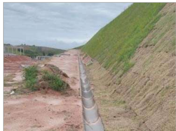
Figura 08 – Modelo de manilha de concreto meia cana instalada em trincheira alteada.
