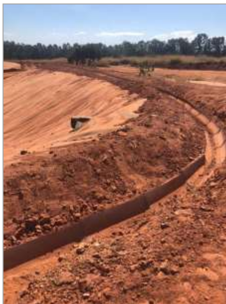
Figura 07 – Detalhe do sistema de drenagem pluvial instalado em trincheiras de aterro sanitário tipo vala.
