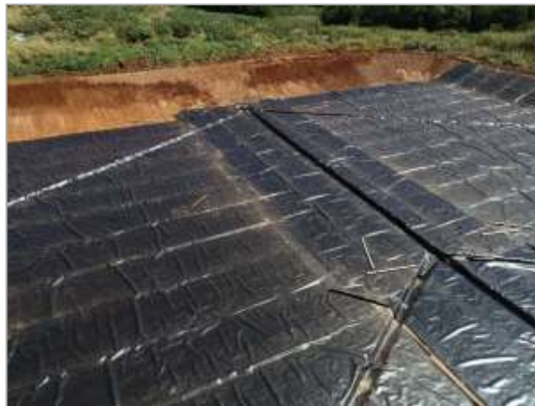
Figura 17 – Exemplo de manta PEAD 2 mm instalada no fundo da trincheira com contornos dos drenos de chorume.
