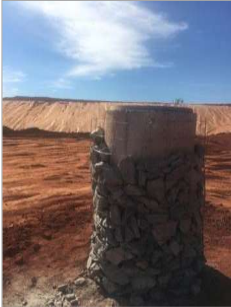
Figura 15 – Manilha de concreto perfurada, envolta na armadura metálica preenchidos com pedra ranchão.
