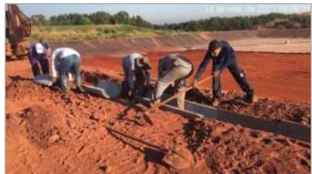
Figura 06 – obras de instalação da manilha meia cana no perímetro da trincheira.
