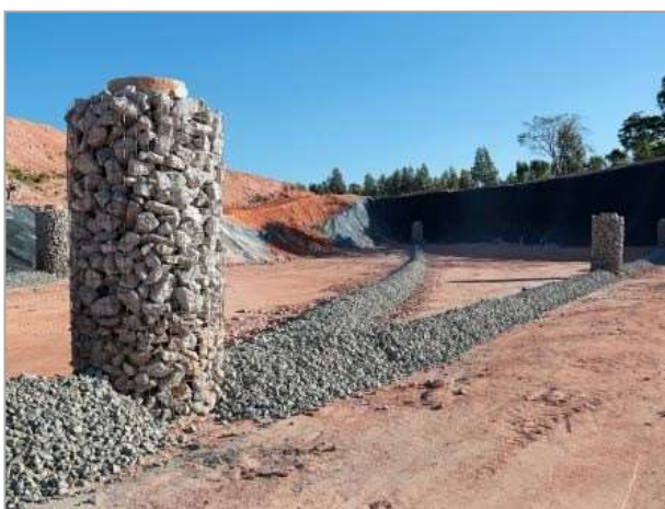
Figura 13 – Dreno de chorume finalizado, com sobressalência de pedra de mão acida do nível domaterial de cobertura da manta (solo argiloso).
